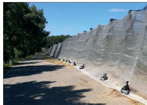
Abb. 3: Ein Bodenabschluss mit Sandsäcken schont das Netzgewebe; Foto: Clemens Augel
